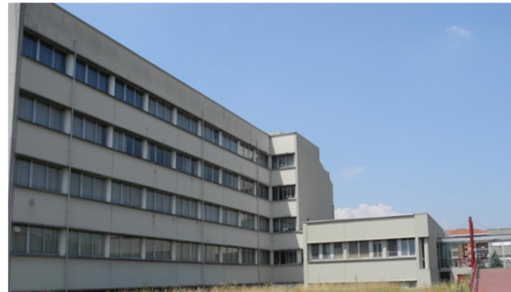
Stante l'irregolarità in pianta ed in elevazione dell'edificio è stata curata in modo particolare la modellazione complessiva dei diversi corpi di fabbrica, prendendo in conto, con successivi modelli parziali l'ipotesi di creazione/adequamento dei giunti in modo da migliorare il comportamento sismico e distribuire correttamente le rigidzze.
