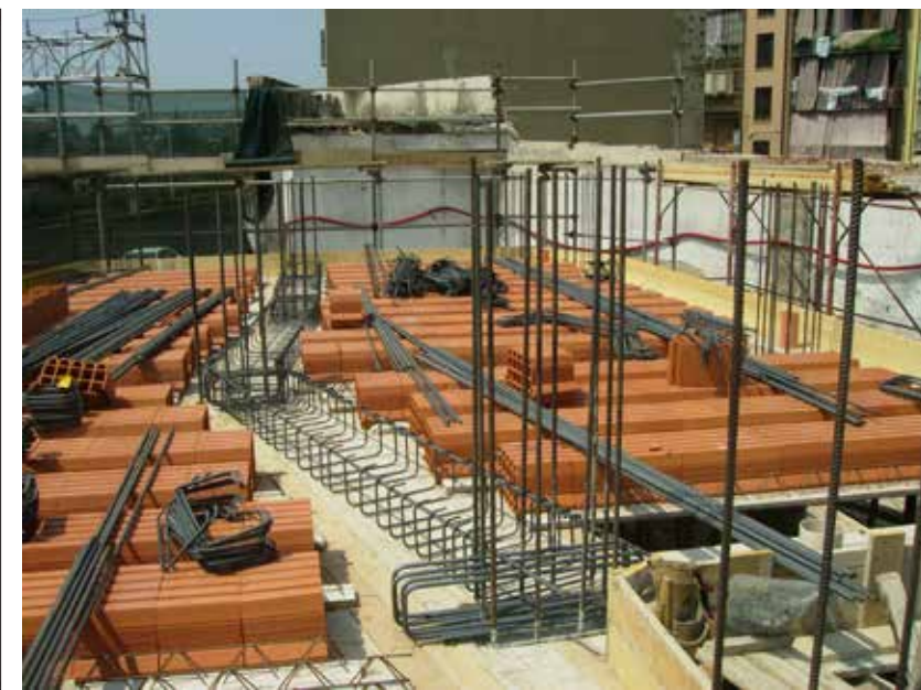
Il cantiere: costruzione del solaio
