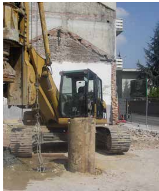
Esecuzione dei pali
