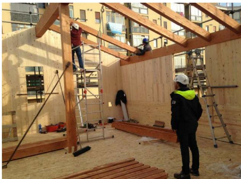
Figura 9 - Montaggio travi su struttura portante in X-LAM
