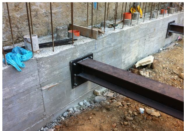
Figura 12 - Travi in acciaio e piastre di collegamento
