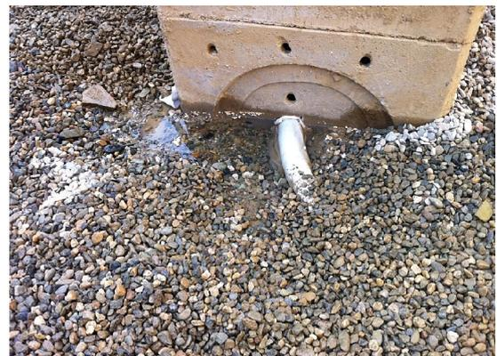
Per ovviare all'inconveniente si è provveduto a realizzare delle opere di drenaggio superficiali: queste hanno l'obiettivo di limitare il ruscellamento superficiale e la conseguente erosione, tenendo sotto controllo le condizioni idrauliche al contorno.
