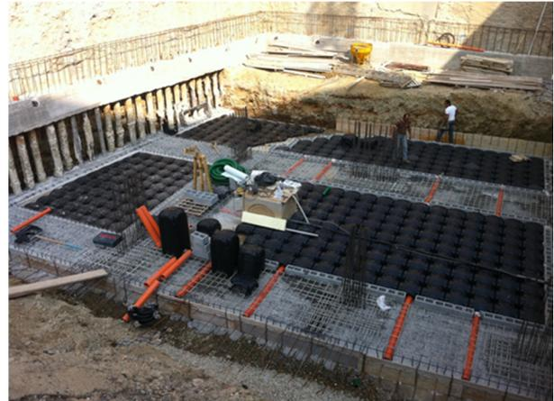
Figura 10 - Armatura di fondazione, parte del getto e gli igloo
