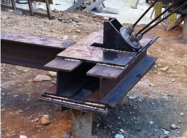
Figura 13 - Vista della struttura in acciaio di ancoraggio
