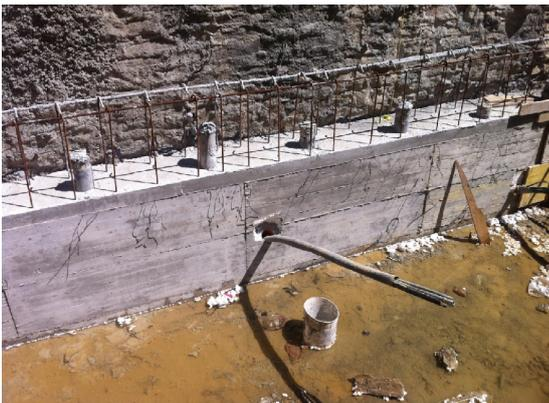
Figura 6 - Trave di sommità con in evidenza la comparsa della falda idrica
