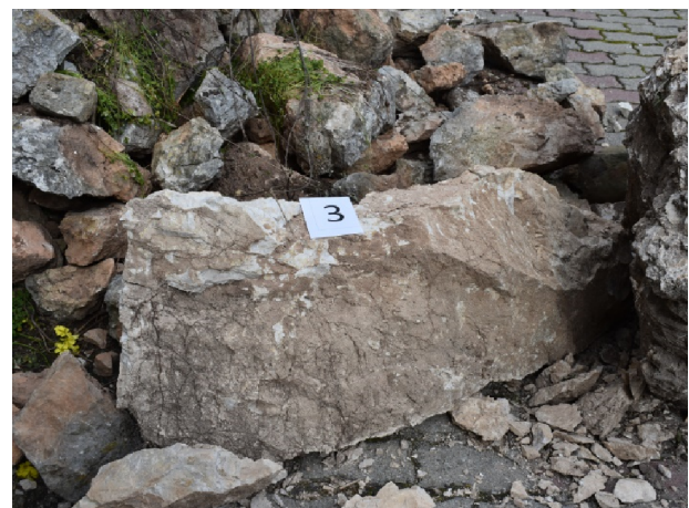
Figura 6 - Foto di blocco caduto
