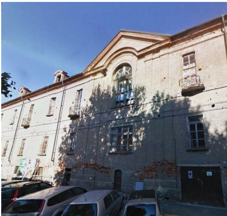
Facciata Sud (estratto da Google Street View)
