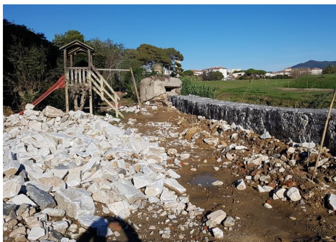
Figura 2 - Danni in seguito all'alluvione
