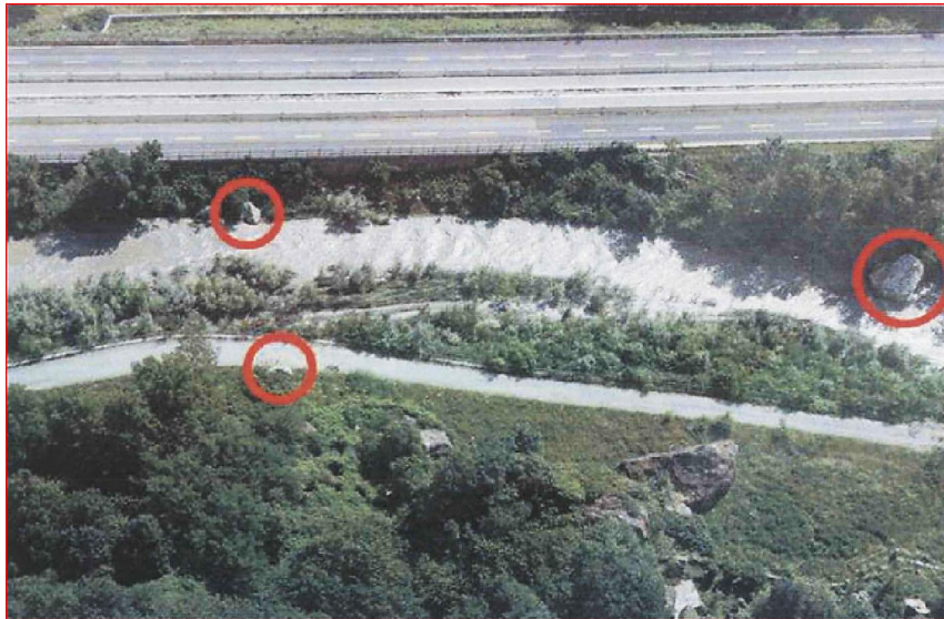
Figura 3 - Blocchi proiettati a ridosso del rilevato autostradale
