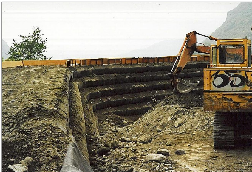
Figura 1 - Foto del paramento di monte di un rilevato paramassi in terra rinforzata in fase di costruzione
