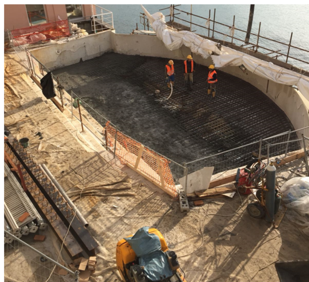
Figura 8 - Posizionamento struttura metallica e posa in opera dell'armatura di fondo della piscina
