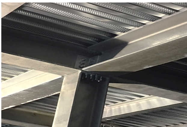
Figura 9 - Nuovo telaio e soprastante solaio in lamiera grecata
