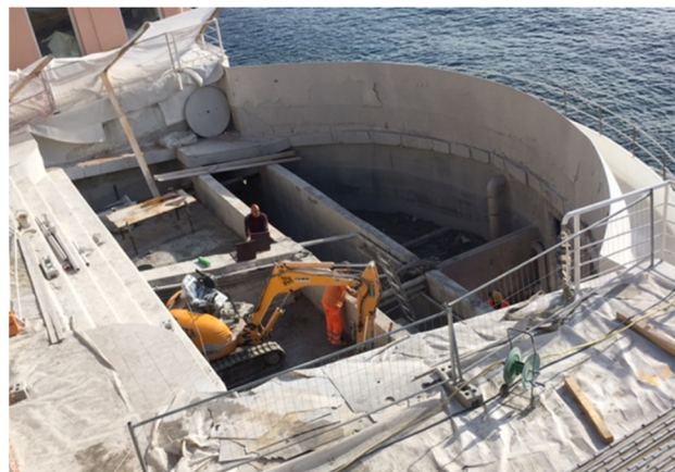
Figura 7 - Operazioni di taglio del solaio di fondo in cemento armato della piscina esterna
