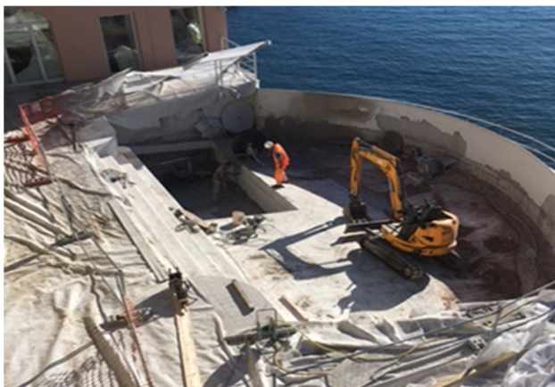
Figura 7 - Operazioni di taglio del solaio di fondo in cemento armato della piscina esterna
