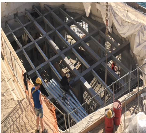
Figura 8 - Posizionamento struttura metallica e posa in opera dell'armatura di fondo della piscina
