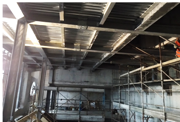
Figura 9 - Nuovo telaio e soprastante solaio in lamiera grecata
